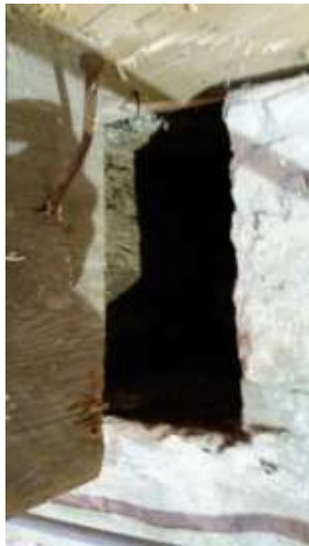
de balkkop afgezaagd
