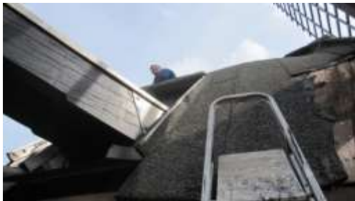
aanbrengen van de nieuwe dakbedekking
