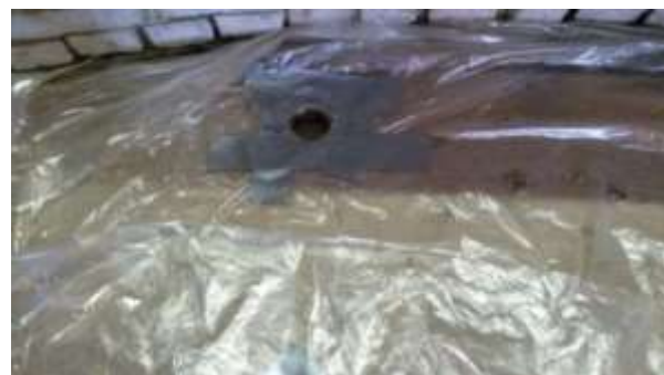
gietgat voor de epoxy vulling
